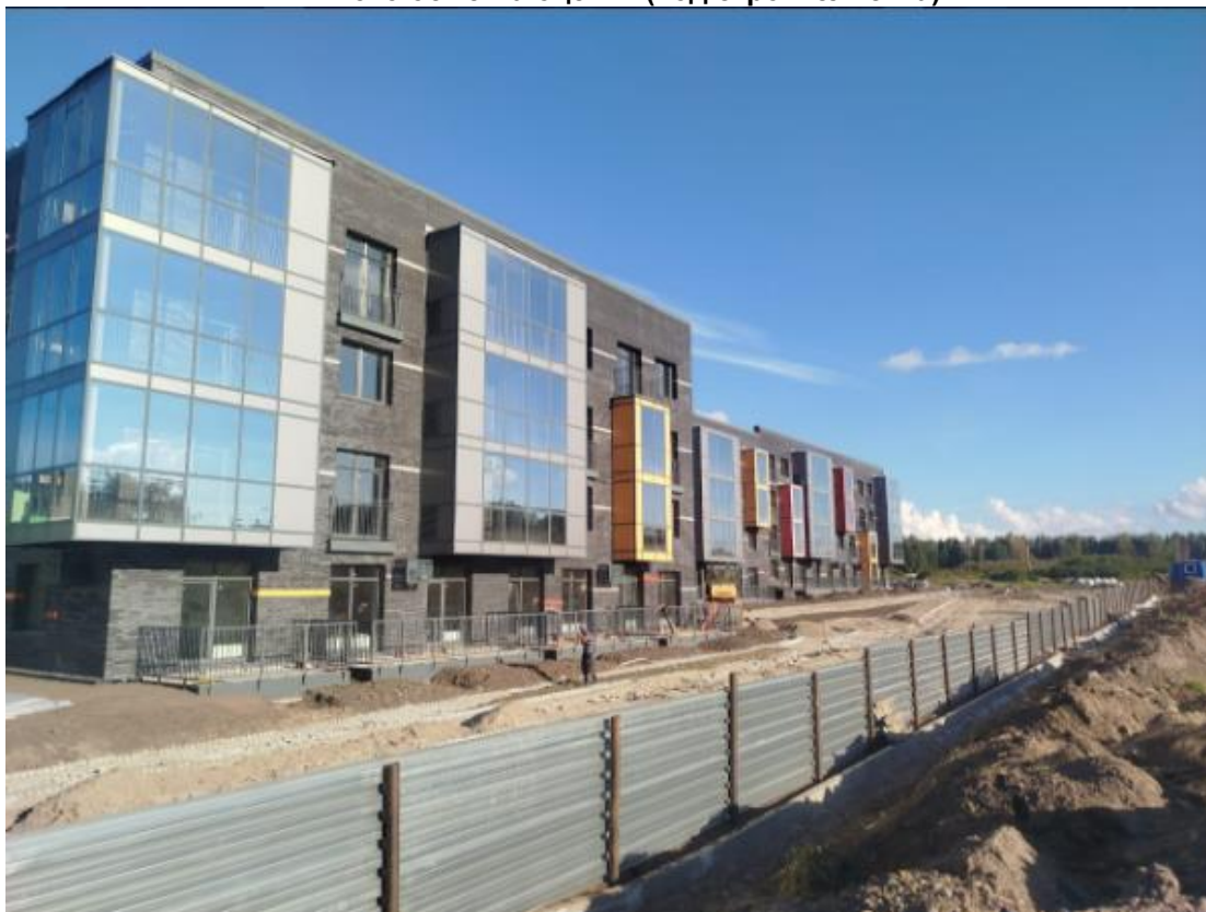
Фото 1. Общий вид жилого дома по состоянию на сентябрь 2025г.
