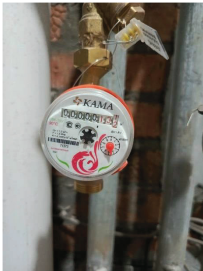
Фото 21. Состояние внутренней отделки кв.119
