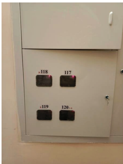
Фото 15. Состояние внутренней отделки кв.119
