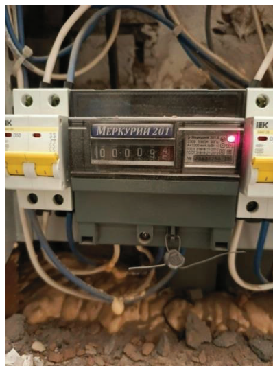
Фото 16. Состояние внутренней отделки кв.119
