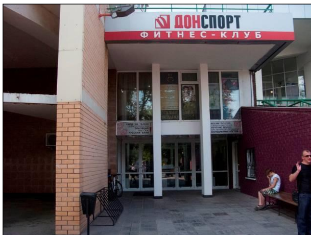
Вход в оцениваемое помещение
