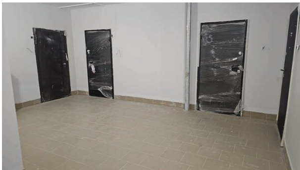
Фото 10. Состояние внутренней отделки кв.71
