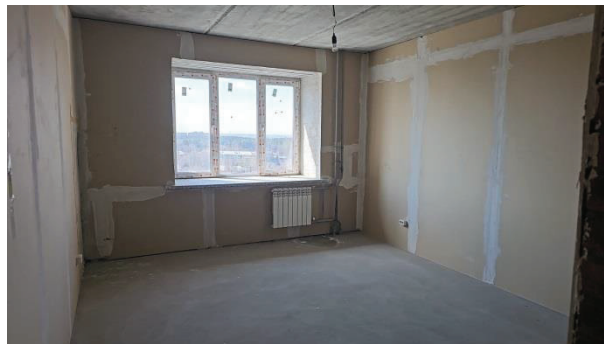
Фото 11. Состояние внутренней отделки кв.71
