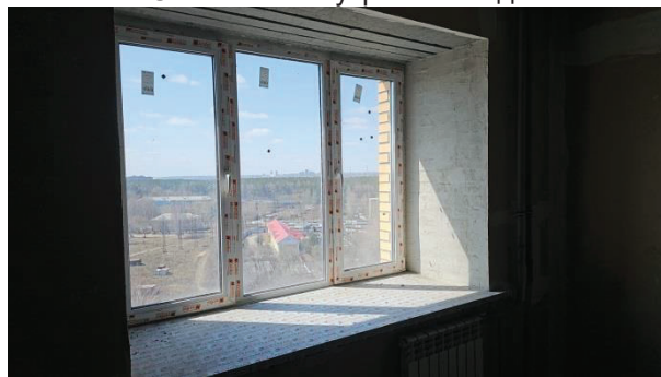
Фото 13. Состояние внутренней отделки кв.71
