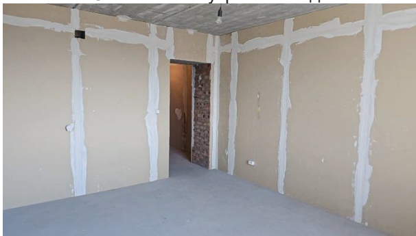
Фото 14. Состояние внутренней отделки кв.71
