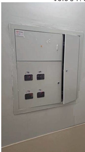
Фото 8. Состояние внутренней отделки кв.71
