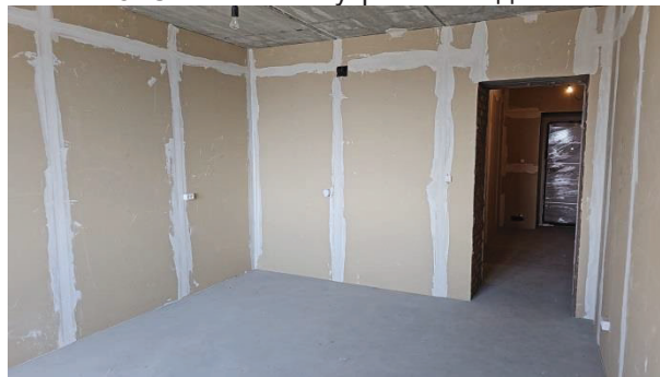
Фото 15. Состояние внутренней отделки кв.71
