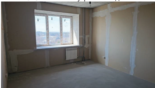
Фото 12. Состояние внутренней отделки кв.71
