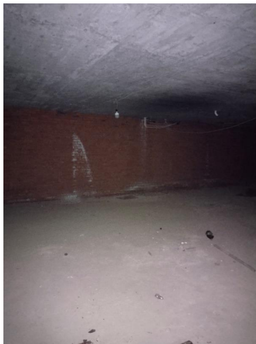
Фрагмент внутренней отделки объекта оценки
