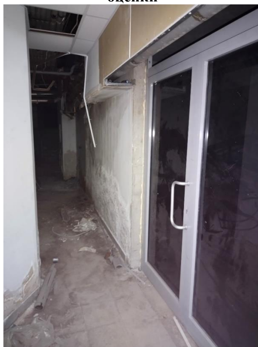
Фрагмент внутренней отделки объекта оценки
