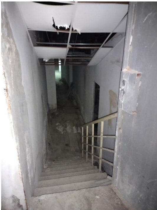
Фрагмент внутренней отделки объекта оценки
