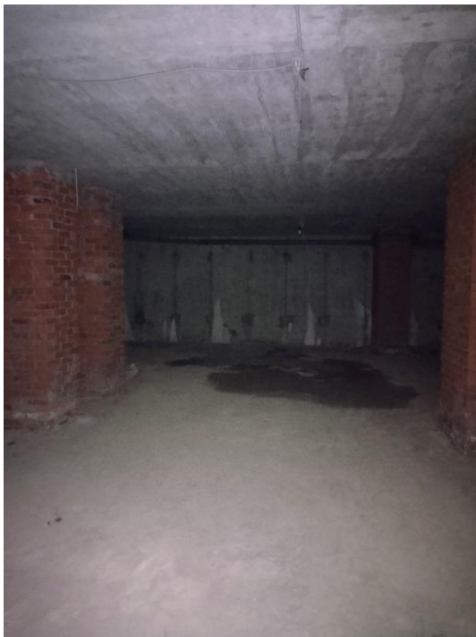
Фрагмент внутренней отделки объекта оценки
