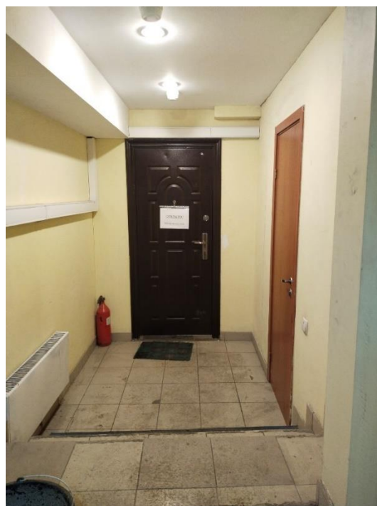
Фрагмент внутренней отделки объекта оценки
