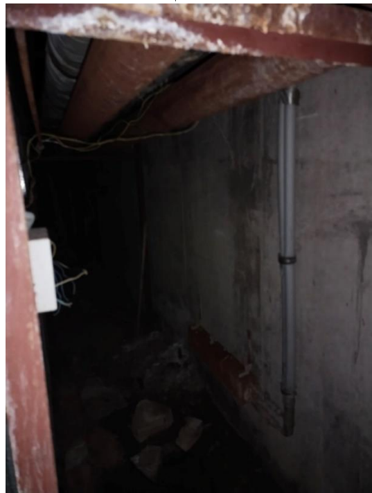
Фрагмент внутренней отделки объекта оценки
