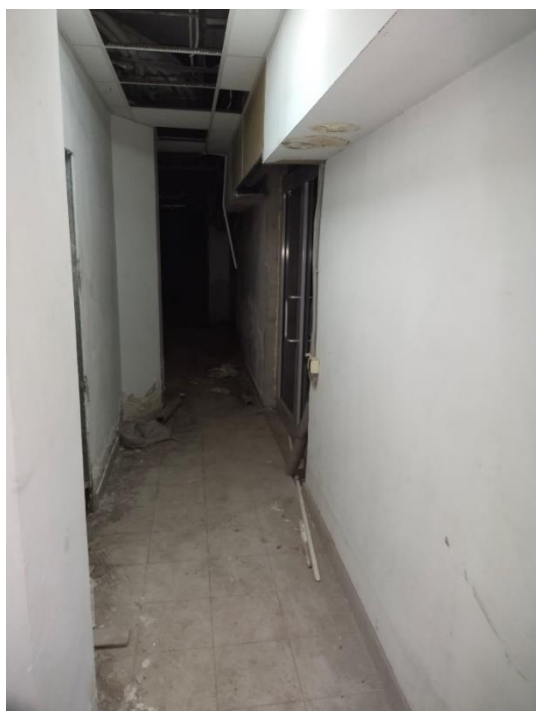
Фрагмент внутренней отделки объекта оценки
