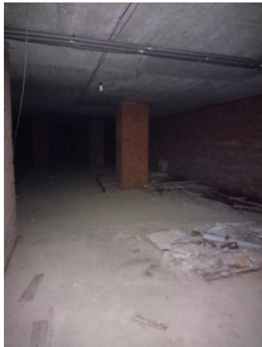
Фрагмент внутренней отделки объекта оценки
