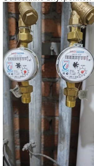
Фото 18. Состояние внутренней отделки кв.34
