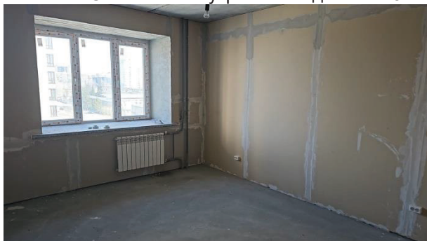
Фото 9. Состояние внутренней отделки кв.34
