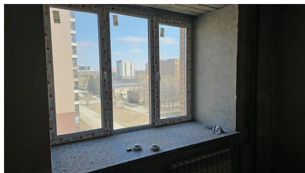
Фото 20. Состояние внутренней отделки кв.34
