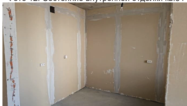
Фото 14. Состояние внутренней отделки кв.34
