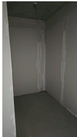
Фото 12. Состояние внутренней отделки кв.34
