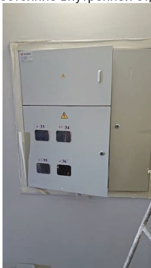
Фото 25. Состояние внутренней отделки кв.34
