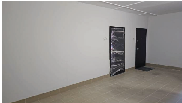
Фото 4. Лестничная площадка 7 этажа
