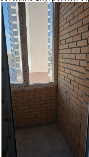
Фото 23. Состояние внутренней отделки кв.34
