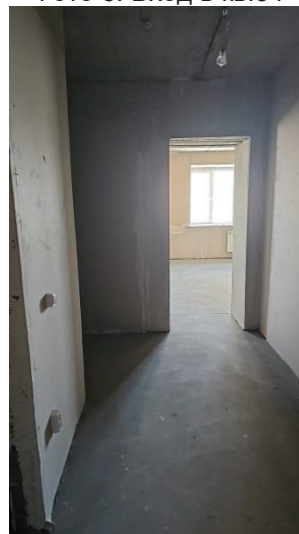
Фото 8. Состояние внутренней отделки кв.34
