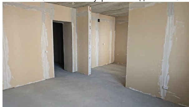
Фото 10. Состояние внутренней отделки кв.34
