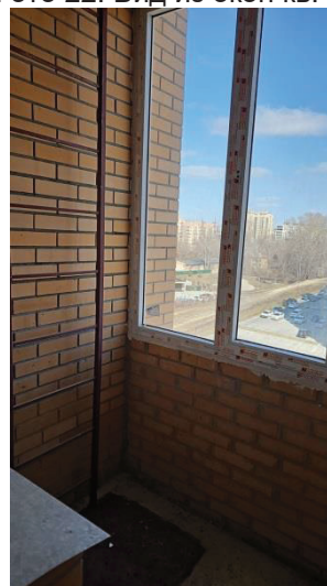
Фото 24. Состояние внутренней отделки кв.34
