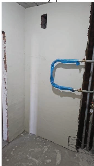
Фото 17. Состояние внутренней отделки кв.34
