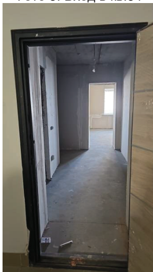
Фото 7. Состояние внутренней отделки кв.34
