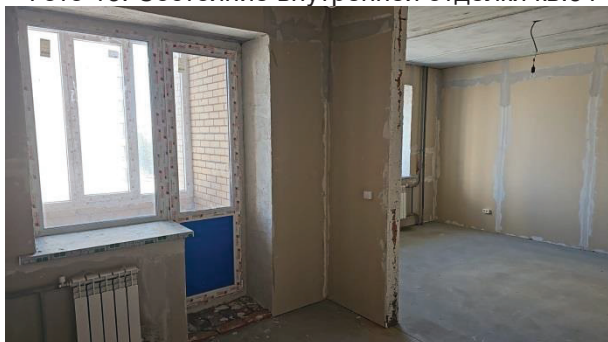
Фото 15. Состояние внутренней отделки кв.34
