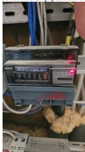
Фото 26. Состояние внутренней отделки кв.34
