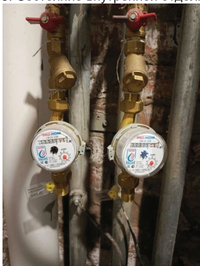
Фото 17. Состояние внутренней отделки кв.70
