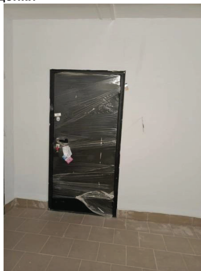
Фото 2. Вход в кв.70
