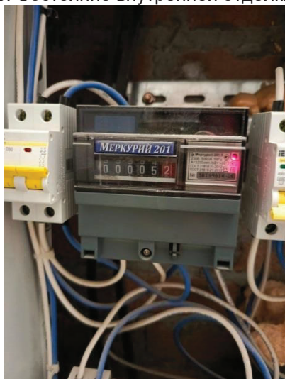
Фото 11. Состояние внутренней отделки кв.70
