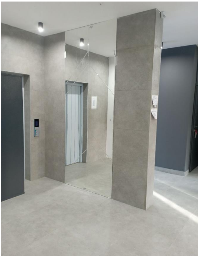
Фото №9 Техническое состояние подъезда
