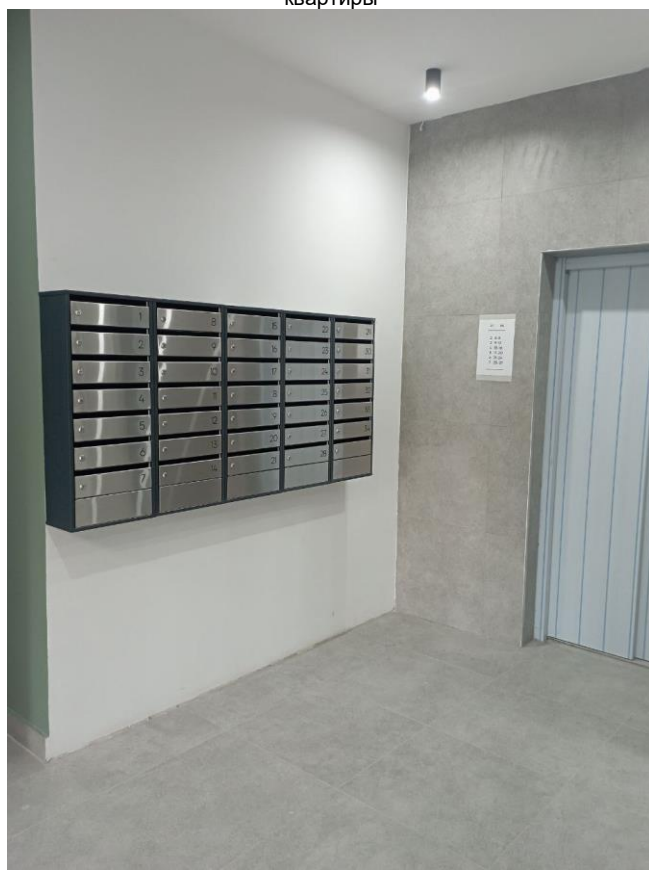
Фото №8 Техническое состояние подъезда
