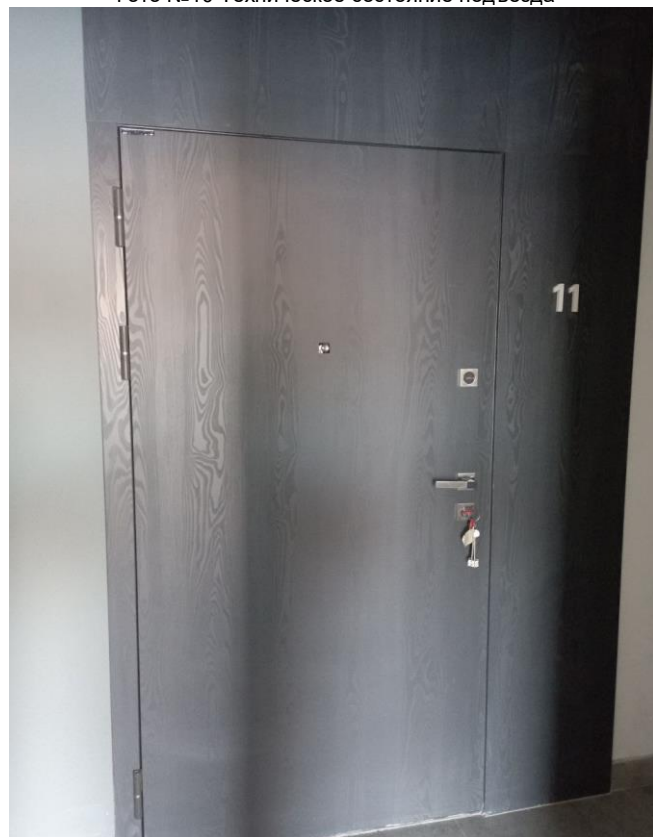
Фото №12 Входная дверь в квартиру
