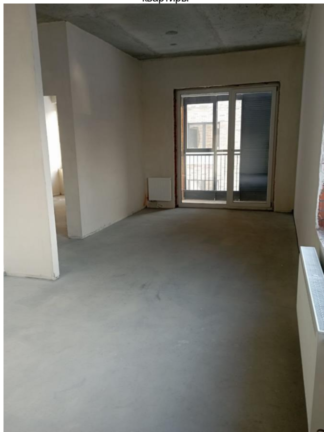
Фото №4 Техническое состояние внутренних помещений квартиры
