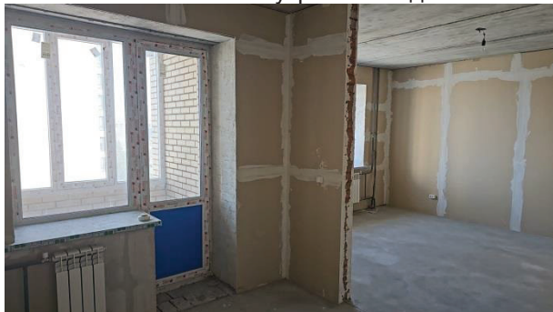
Фото 15. Состояние внутренней отделки кв. 66
