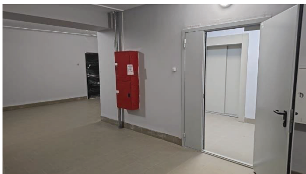
Фото 3. Лестничная площадка 11 этажа
