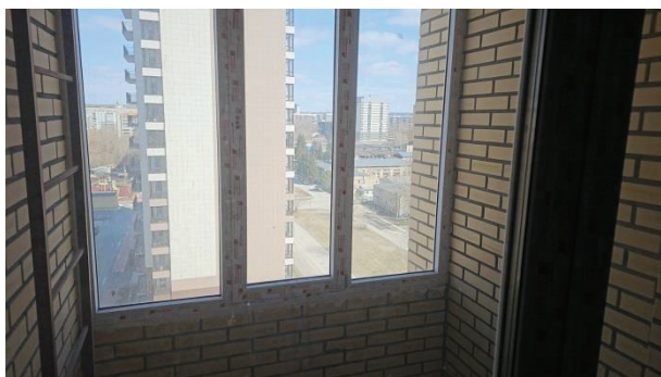
Фото 19. Состояние внутренней отделки кв. 66
