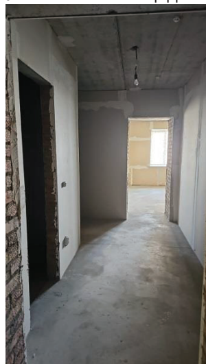
Фото 6. Состояние внутренней отделки кв. 66
