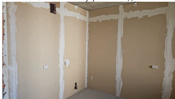
Фото 10. Состояние внутренней отделки кв. 66
