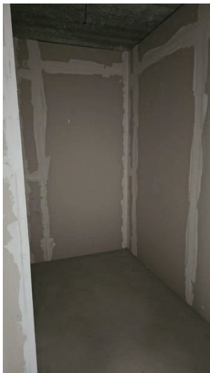
Фото 11. Состояние внутренней отделки кв. 66
