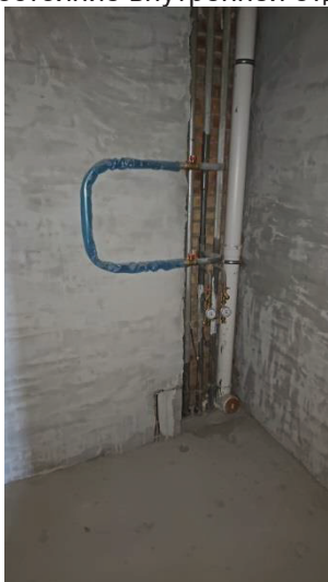
Фото 17. Состояние внутренней отделки кв. 66
