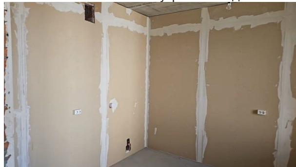
Фото 16. Состояние внутренней отделки кв. 66
