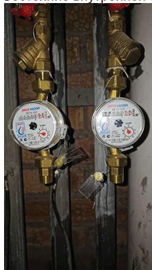
Фото 18. Состояние внутренней отделки кв. 66
