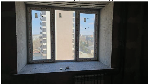
Фото 21. Состояние внутренней отделки кв. 66
