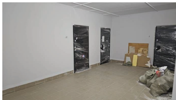
Фото 4. Лестничная площадка 11 этажа
