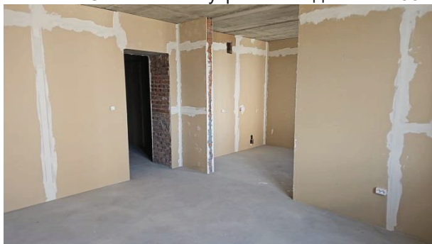
Фото 9. Состояние внутренней отделки кв. 66
