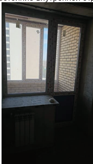
Фото 23. Состояние внутренней отделки кв. 66
