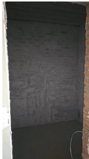
Фото 12. Состояние внутренней отделки кв. 66
