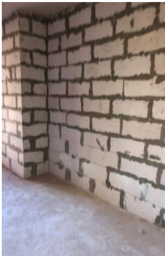
Фото 12. Состояние внутренней отделки кв.63
