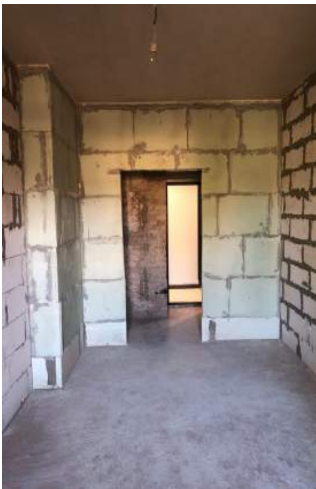
Фото 11. Состояние внутренней отделки кв.63
