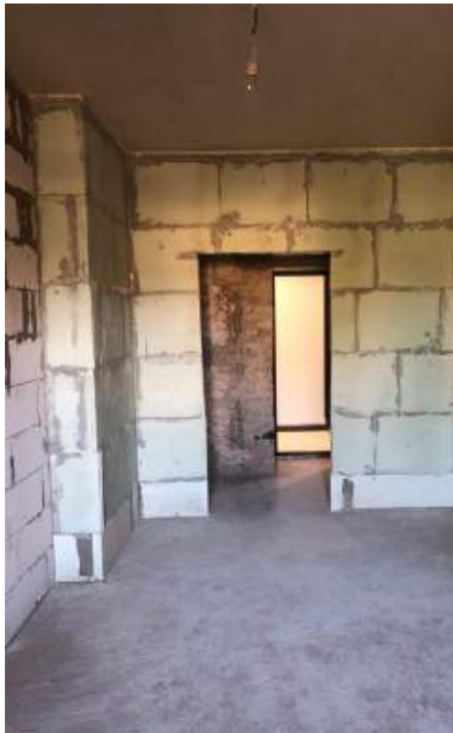
Фото 9. Состояние внутренней отделки кв.63
