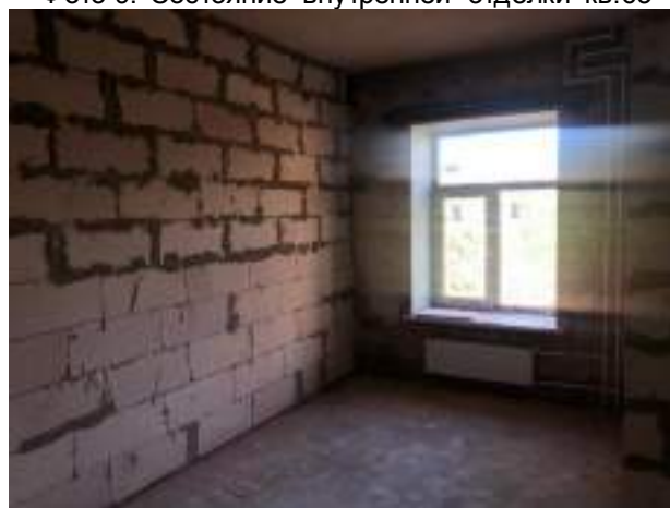
Фото 10. Состояние внутренней отделки кв.63
