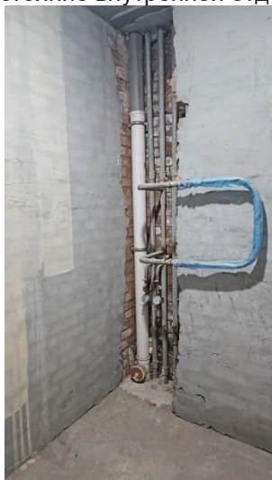
Фото 9. Состояние внутренней отделки кв.118
