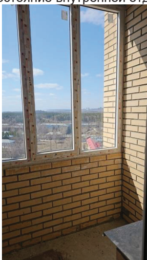
Фото 17. Состояние внутренней отделки кв.118
