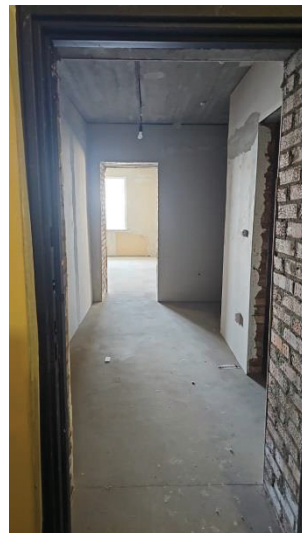
Фото 4. Состояние внутренней отделки кв.118
