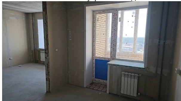
Фото 8. Состояние внутренней отделки кв.118
