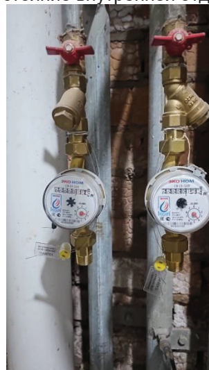
Фото 10. Состояние внутренней отделки кв.118
