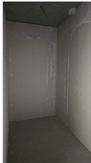
Фото 12. Состояние внутренней отделки кв.118
