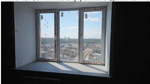
Фото 15. Состояние внутренней отделки кв.118
