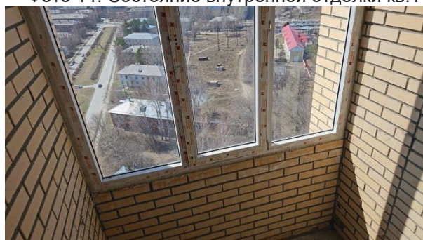
Фото 16. Состояние внутренней отделки кв.118
