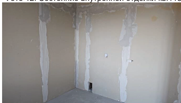
Фото 14. Состояние внутренней отделки кв.118
