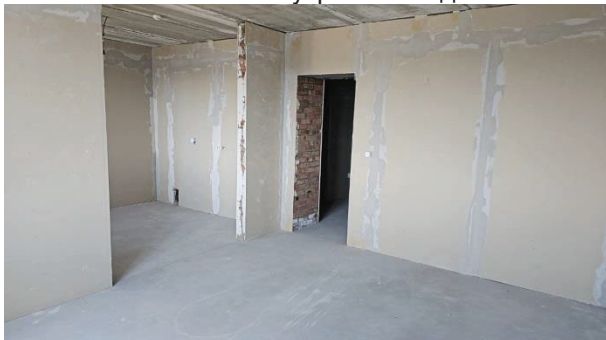
Фото 7. Состояние внутренней отделки кв.118
