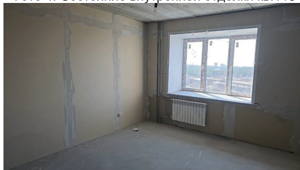
Фото 6. Состояние внутренней отделки кв.118
