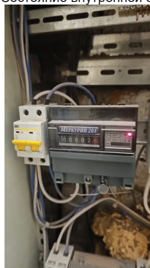
Фото 18. Состояние внутренней отделки кв.118
