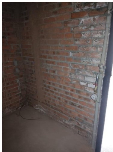
Фото 8. Состояние внутренней отделки кв.128
