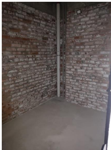
Фото 2. Состояние внутренней отделки кв.128
