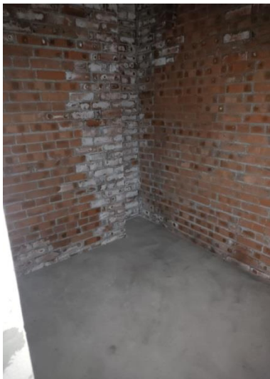
Фото 7. Состояние внутренней отделки кв.128
