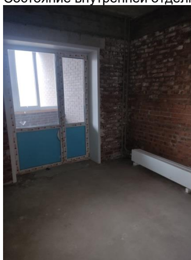
Фото 6. Состояние внутренней отделки кв.128
