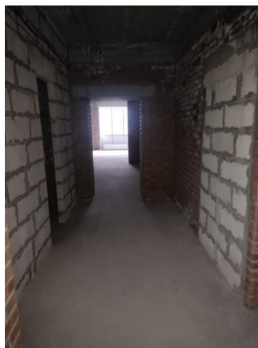
Фото 10. Состояние внутренней отделки кв.128
