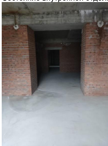
Фото 4. Состояние внутренней отделки кв.128
