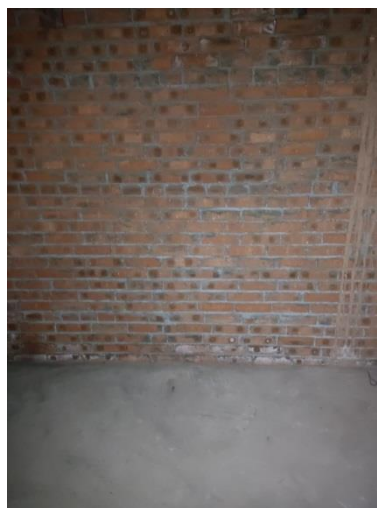
Фото 12. Состояние внутренней отделки кв.128
