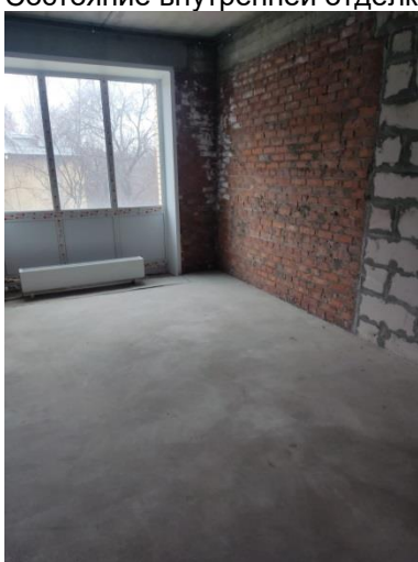
Фото 5. Состояние внутренней отделки кв.128
