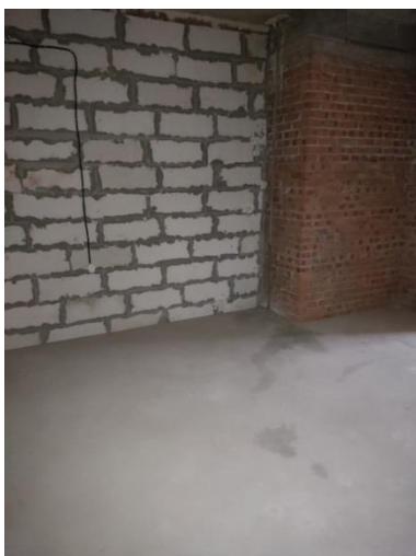
Фото 9. Состояние внутренней отделки кв.128
