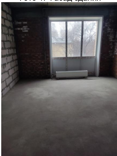
Фото 3. Состояние внутренней отделки кв.128
