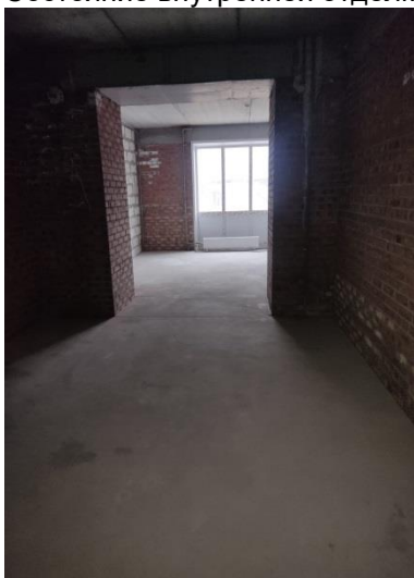
Фото 11. Состояние внутренней отделки кв.128
