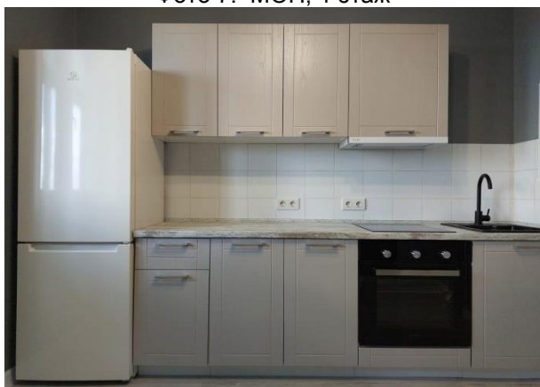
Фото 9. Состояние внутренней отделки кв.82
