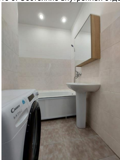
Фото 11. Состояние внутренней отделки кв.82
