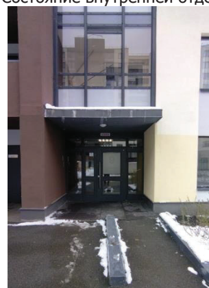
Фото 14. Вход в подъезд
