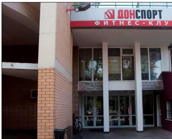
Вход в оцениваемое помещение
