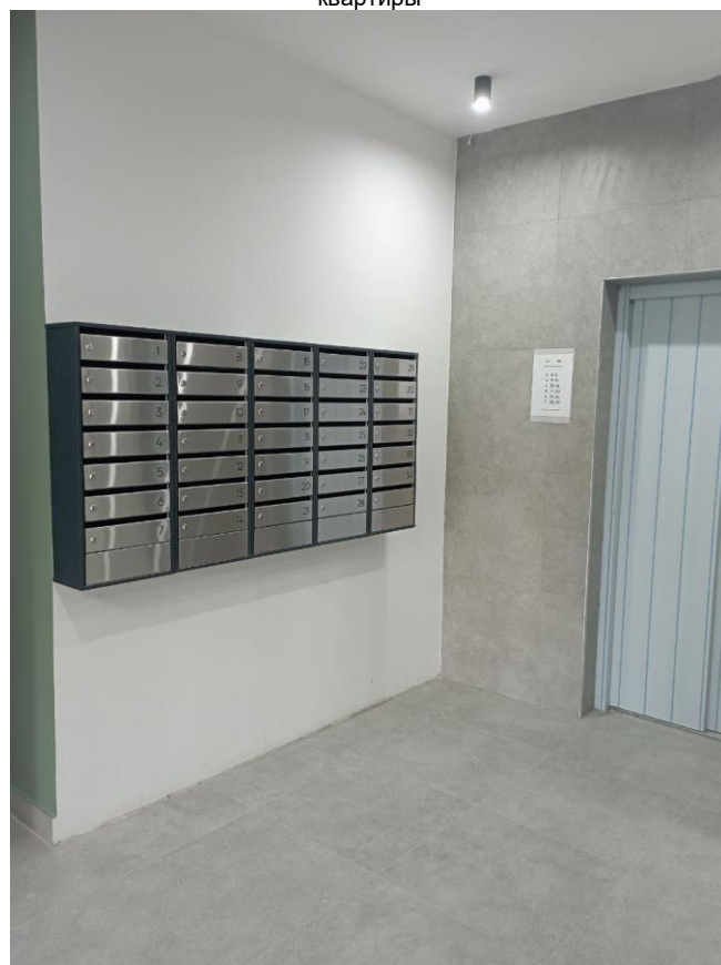
Фото №8 Техническое состояние подъезда
