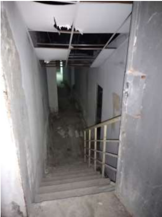
Фрагмент внутренней отделки объекта оценки
