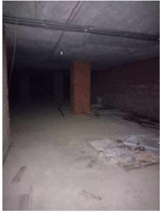
Фрагмент внутренней отделки объекта оценки
