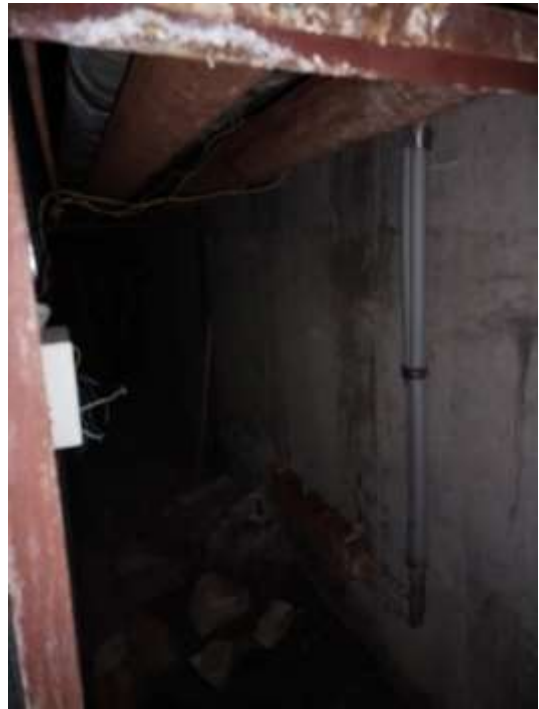
Фрагмент внутренней отделки объекта оценки
