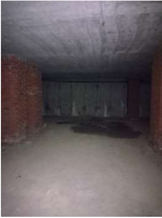
Фрагмент внутренней отделки объекта оценки
