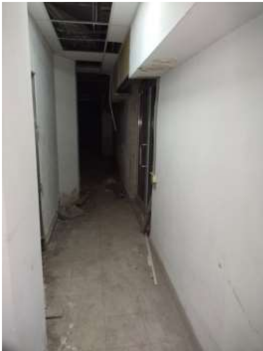
Фрагмент внутренней отделки объекта оценки
