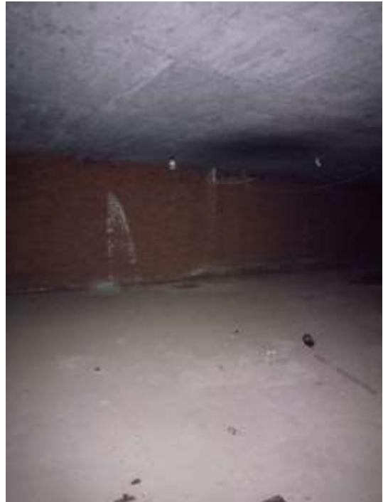
Фрагмент внутренней отделки объекта оценки
