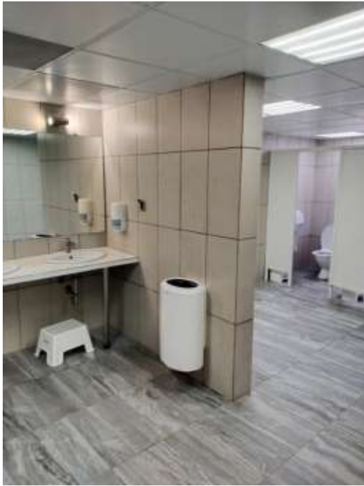
Фрагмент внутренней отделки объекта оценки
