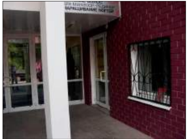
Вход в оцениваемое помещение
