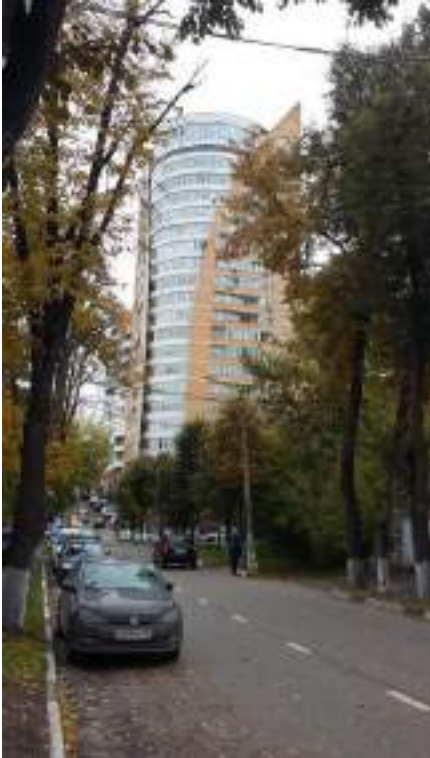
Общий вид здания
