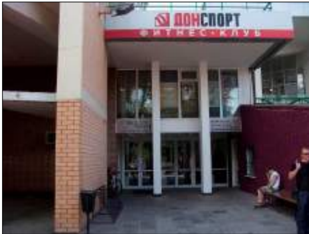
Вход в оцениваемое помещение
