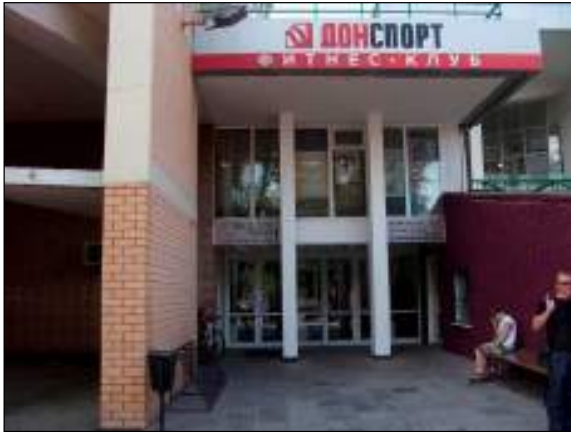
Вход в оцениваемое помещение
