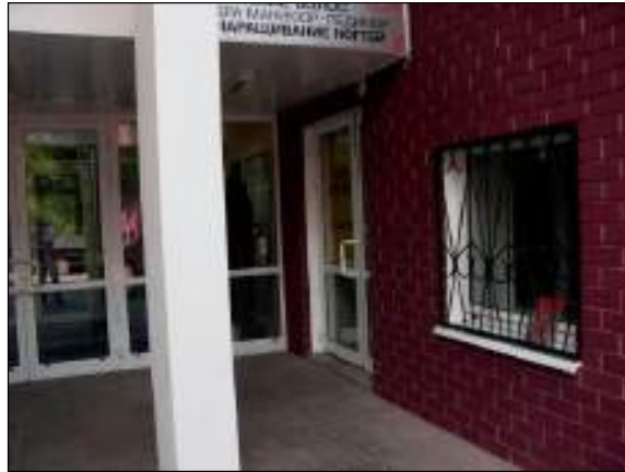
Вход в оцениваемое помещение
